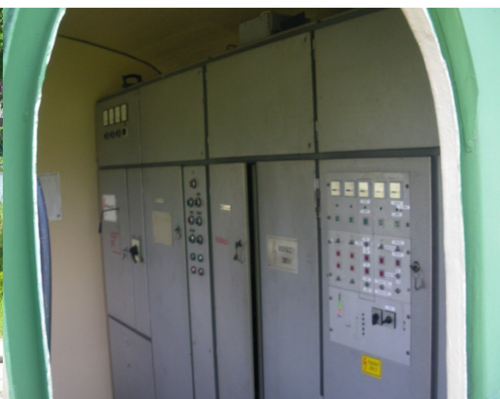
I-es vízműtelep kezelő polidom és benne lévő főkapcsoló szekrény
