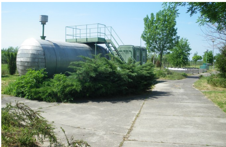
II-es vízműtelep felszíni tároló
